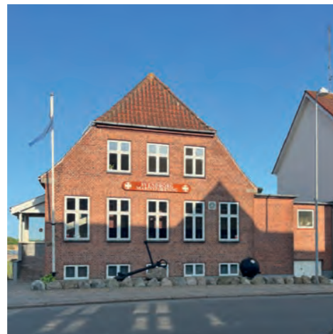
Den røde gavl mod gaden Færgevej 5
